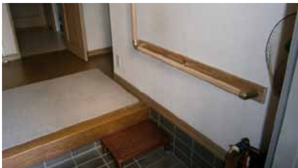
手すりと踏み台を設置することで安全に外出できます。
